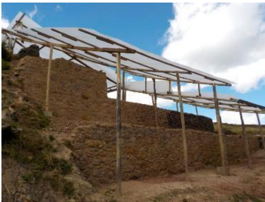
Fig. 05. Vista NW-SE de los muros 9, 10 y 10a restaurados.
