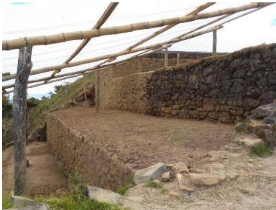
Fig. 06. Vista SW-NE de los muros 9, 10 y 10a restaurados.
