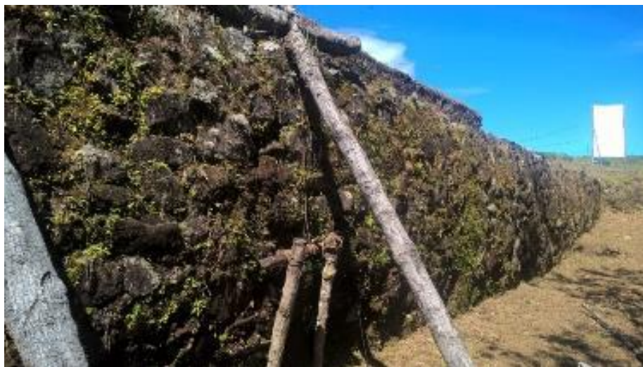
Fig.04. Vista general del muro 10 antes de su intervención.
