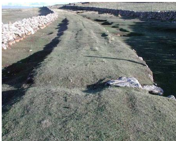
Tramo Pumpu - Chacamarca. Foto Archivo Proyecto Qhapaq Ñan
