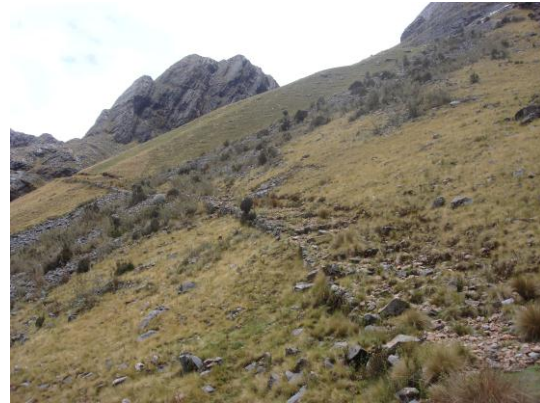
Camino que presenta muro de contención
