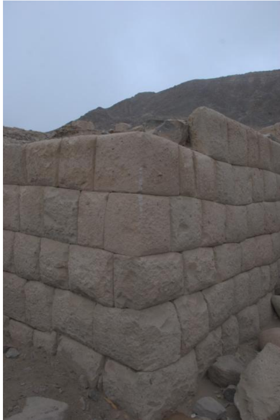
Foto 1. Detalle de la Esquina NW del "Gran Recinto" levantado con sillería fina, excavado por el INC en 1987. Vista al SE (foto de José Luis Matos, 2012).
