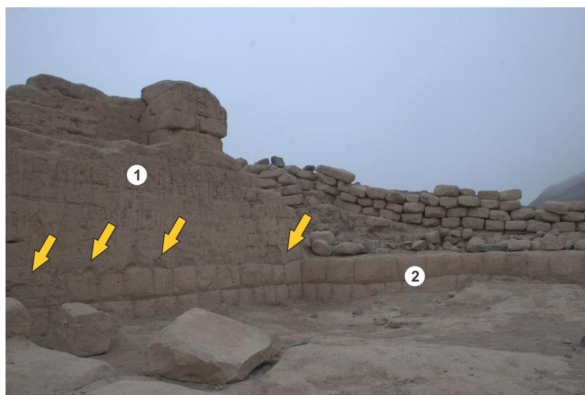
Figura 8. Indicaciones de la última actividad constructiva en el recinto anexo al sur del "Torreón", donde se evidencia la cobertura del enlucido de los muros de adobes paralelepípedos (1) sobre el paramento de los muros con sillares (2). Sector 1, vista al NE (foto de J. L. Matos; ilustración de R. Peralta, 2012).
