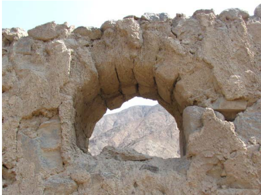
Fotos 2 y 3: ventana con arco de medio punto (izquierda), soporte de escalera con arco angular (derecha), ambos elaborados en base a adobes.
