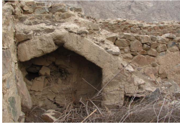
Fotos 2 y 3: ventana con arco de medio punto (izquierda), soporte de escalera con arco angular (derecha), ambos elaborados en base a adobes.
