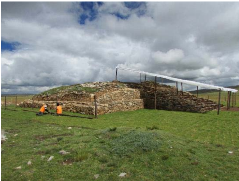
Foto 4. Vista del Ushnu durante los trabajos de conservación
