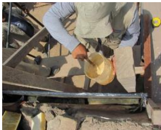
Foto 10: Preparando el poliuretano expansivo
