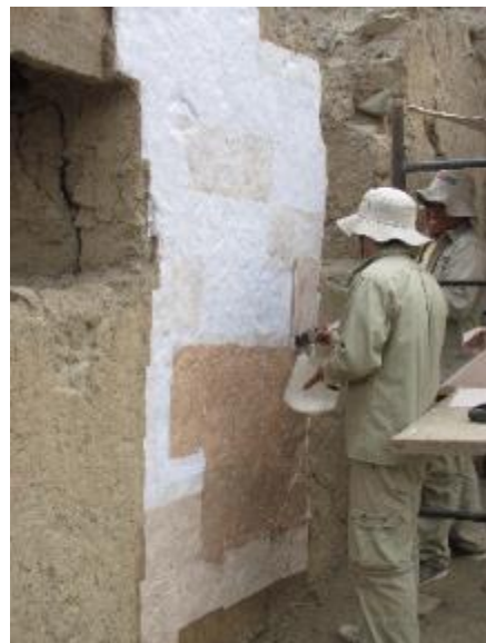
Foto 9: Protección de superficie aplicando capas de papel
