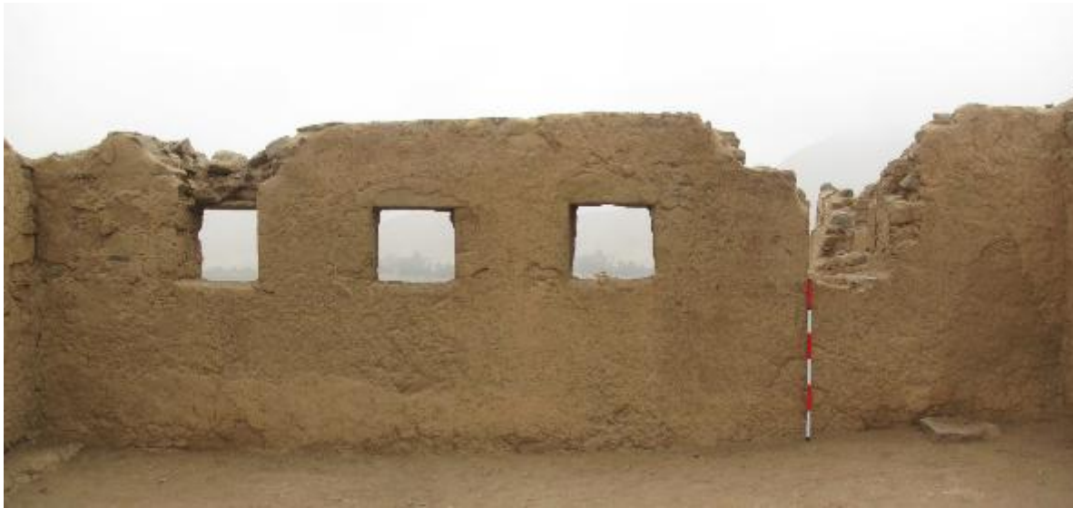
Foto 23: Vista frontal después de la consolidación
