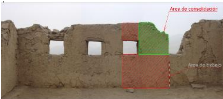
Foto 7: Área de intervención estructural y área de apuntalamiento
