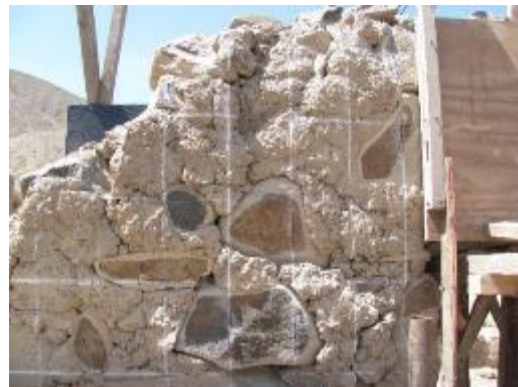
Foto 13: codificación de mampostería
