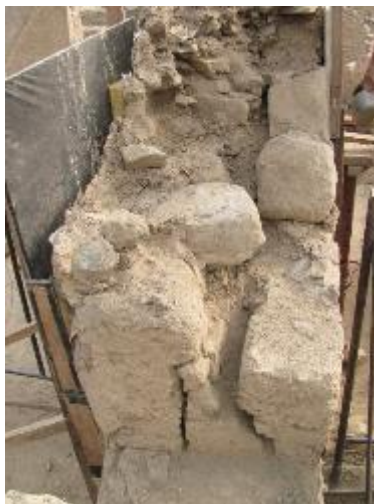
Foto 14, 15 y 16: Proceso del desmontaje de las unidades de mampostería (piedra y adobe)
