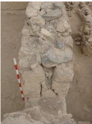
Foto 14, 15 y 16: Proceso del desmontaje de las unidades de mampostería (piedra y adobe)
