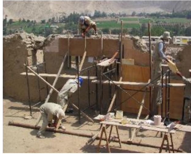
Foto 12: Apuntalamiento estructural muro MG-178
