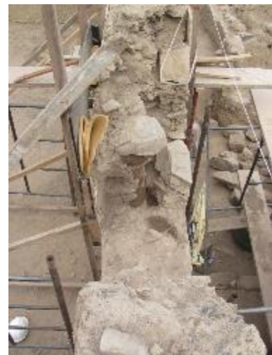
Foto 14, 15 y 16: Proceso del desmontaje de las unidades de mampostería (piedra y adobe)
