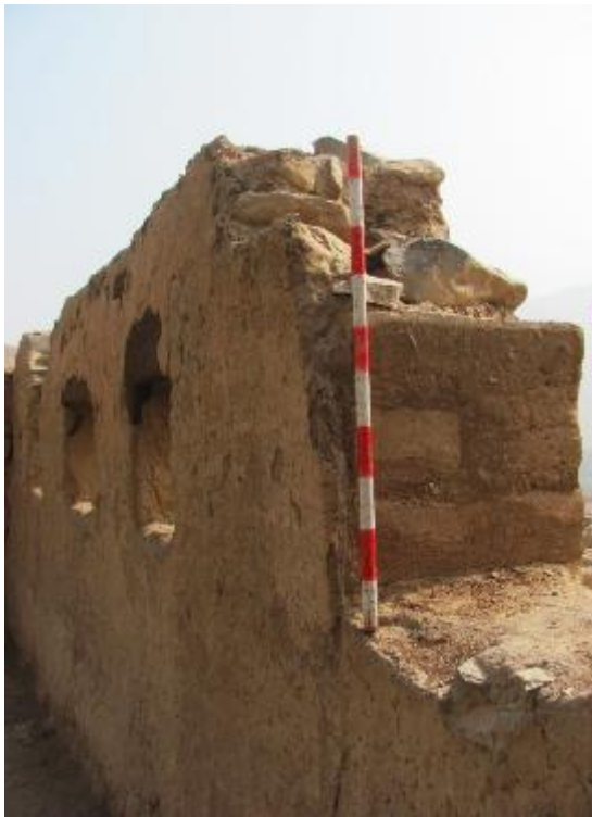
Foto 25: Detalle de la sección de muro consolidado
