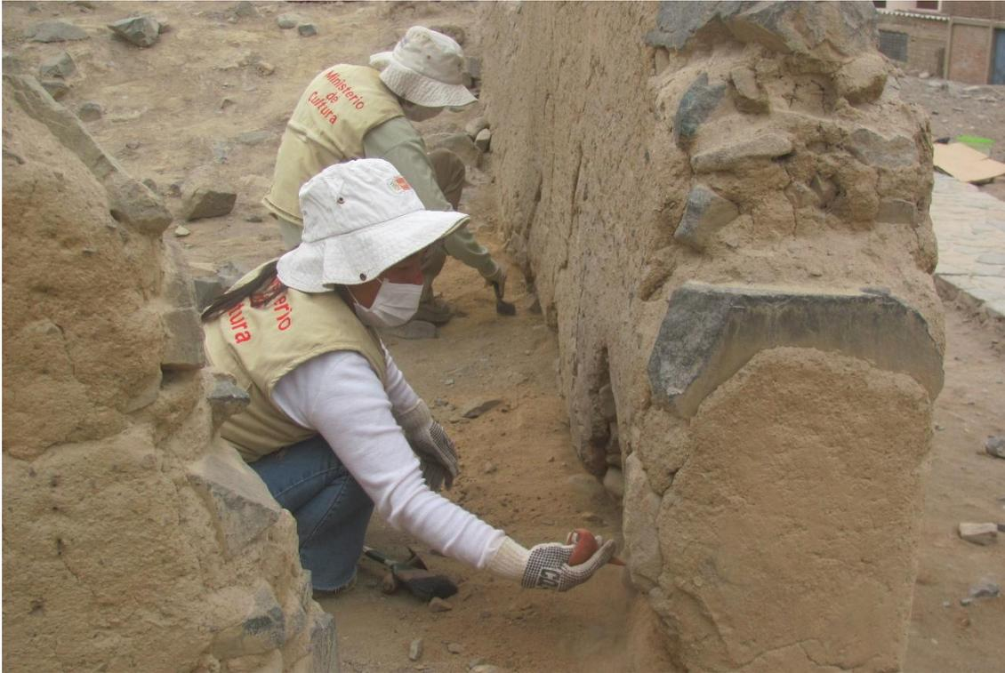
*Limpieza previa al emboquillado, como parte de las acciones de consolidación estructural.*
