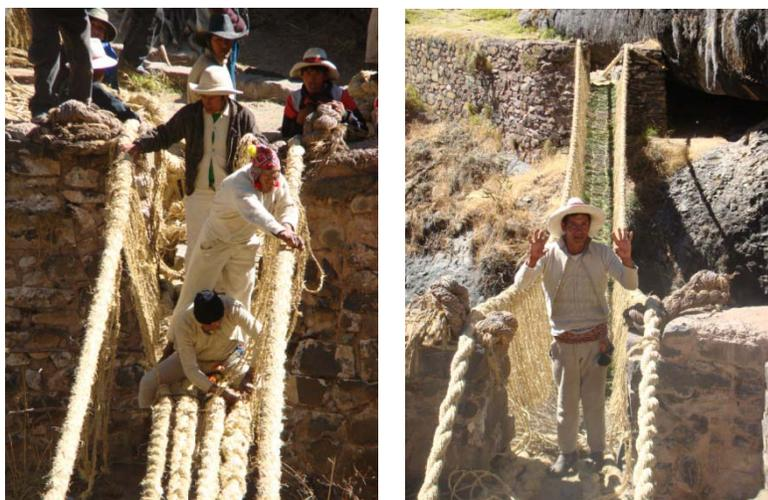
**Fig. N° 1 y 2: Imágenes del proceso de renovación del Puente Q´eswachaka**
