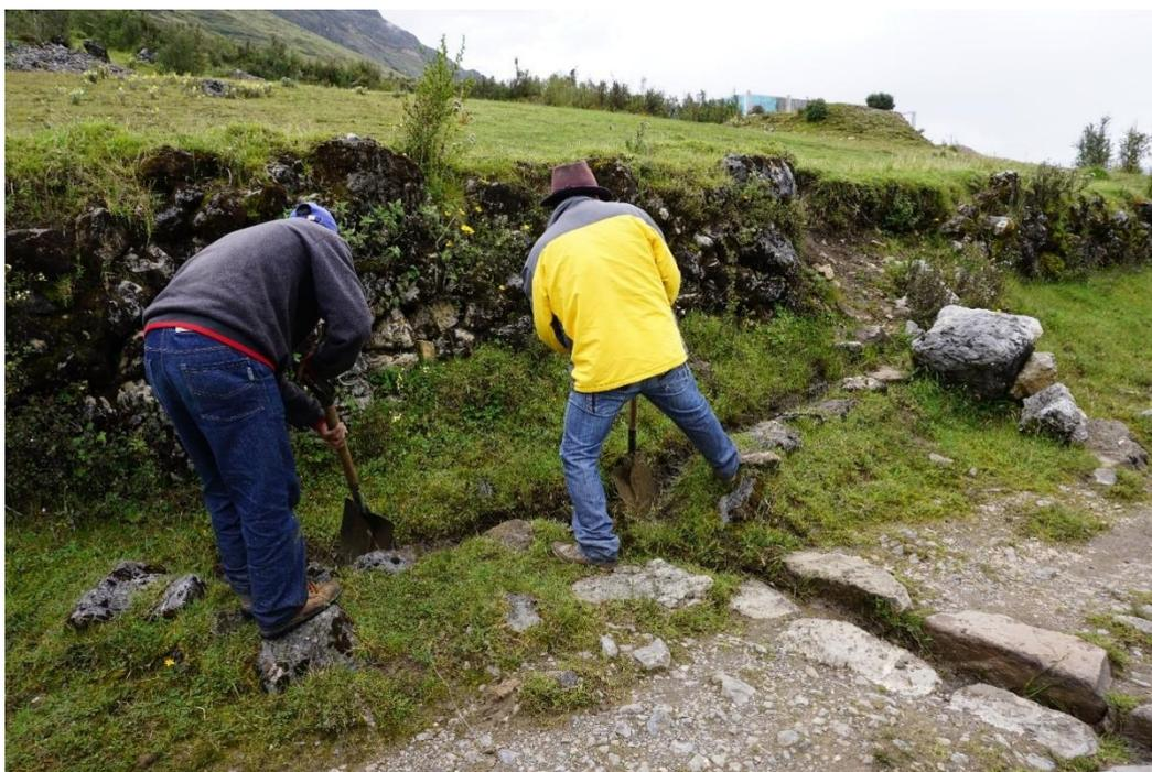
Fig. 2 Limpieza de drenes y descolmatación de canales para evitar los desbordes e inundaciones
