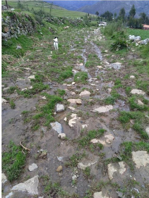
Fig. 8 Vista panorámica de la calzada del camino, los aniegos y escorrentías de agua eran una afectación constante
