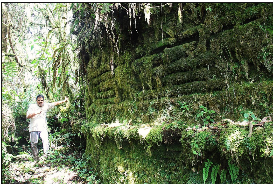
Figura 5: Edificio 1, investigado por Duccio Bonavía (1966) y Warren Church (1985).
