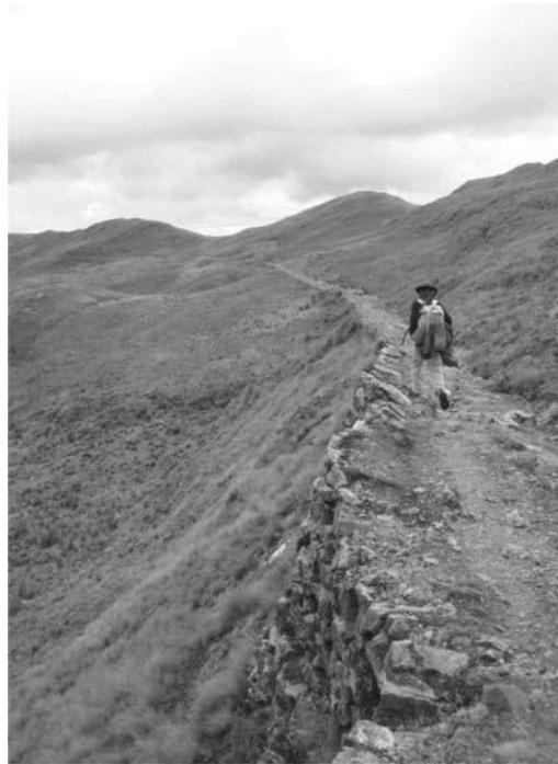
Figura 5. Camino tipo Plataforma Corte-Talud, en las alturas de la provincia de Huari (Ancash). Fuente: Ricardo Chirinos Portocarrero/PQÑ.
