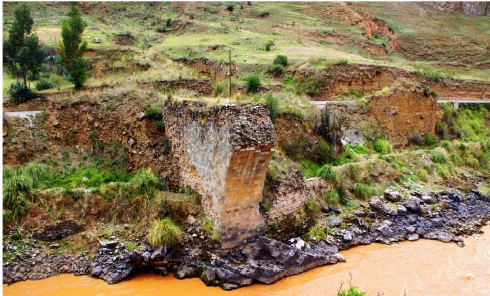
Figura 02: Restos de puente de cal y canto en el sitio arqueológico de Hatun Chaka, construido en 1552 por orden del virrey Marqués de Cañete (Fotografía: Proyecto de Tramo Xauxa-Pachacamac).
