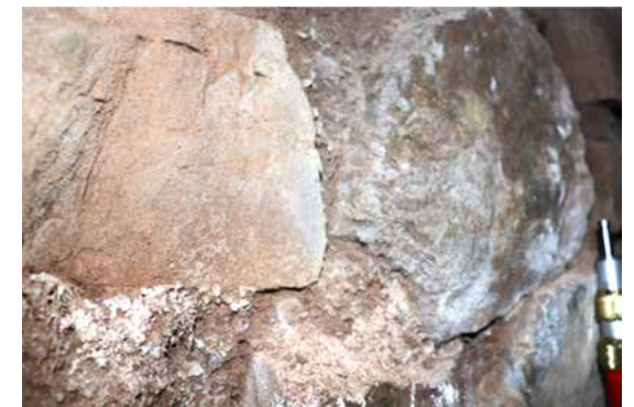
Foto 7. Detalle del nivel de cristalización de sales sobre secciones de las paredes de la Galería El Lanzón.
