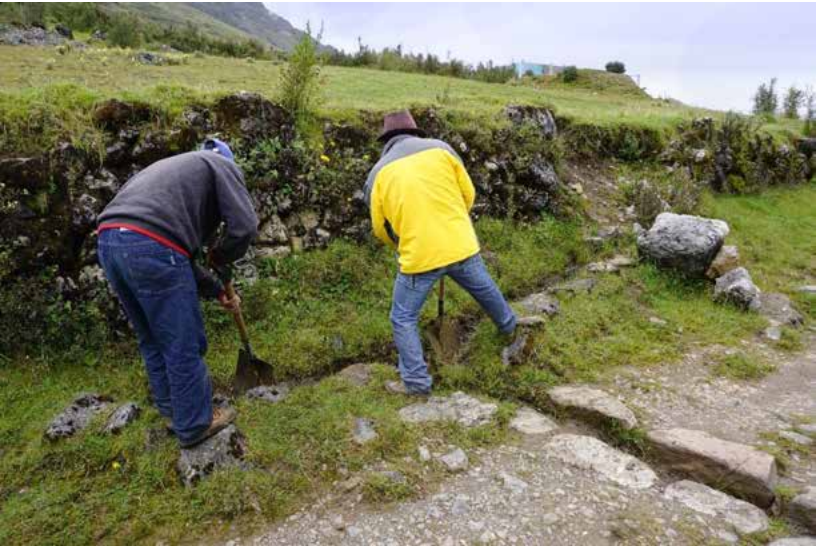
Foto 2. Limpieza de drenes y descolmatación de canales para evitar los desbordes e inundaciones.
