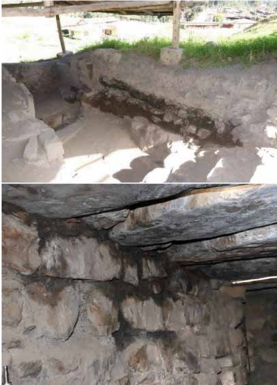
Fotos 3 y 4. Detalle de filtraciones debajo de las áreas techadas y filtración dentro de la Galería El Lanzón.
