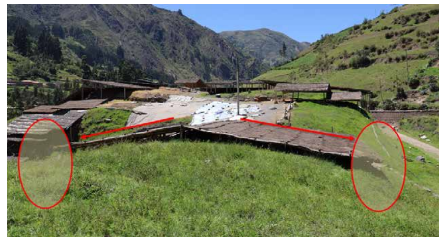
Foto 2. Sistemas de cobertores y techos a dos aguas en la cima del Edificio B, sobre la Galería El Lanzón, indicando las áreas de desfogue (círculos rojos) al lado este y oeste.
