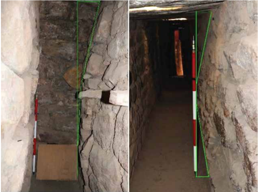
Fotos 8 y 9. Problemas de pandeo en la Cámara Principal y el Corredor Central.
