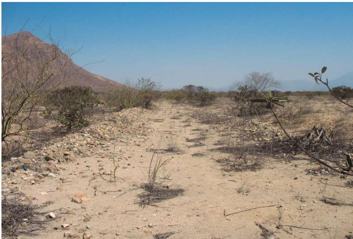
Foto 4. Camino A1, vista de sur a norte. Este tramo tiene una calzada elevada con canales en cada lado
