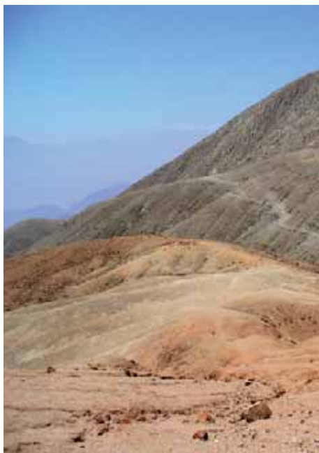
Fig. 12. Parte del camino con muro de contención en la parte alta de Quebrada Venturosa. Véase la pendiente tan accidentada.
