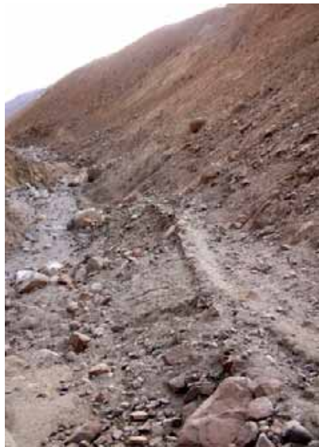
Fig. 16. Segmento IV de Quebrada Cerro Hueco, muros de contención que definen el camino.
