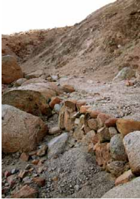
Fig. 14. Segmento II de Quebrada Cerro Hueco. Muros de contención que definen el camino.
