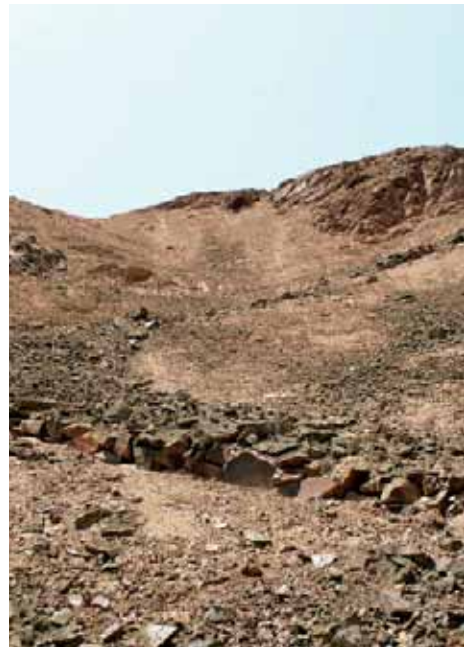
Fig. 30. Segmento VIII de Quebrada Culebrilla. Muro de contención del camino en su ascenso hacia el abra del Cerro Mendoza.
