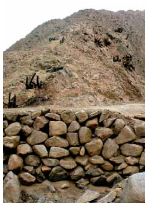
Fig. 26. Segmento VII de Quebrada Culebrilla. Muro de contención de 1.20 m de alto y un ancho máximo de vía de 6 m.
