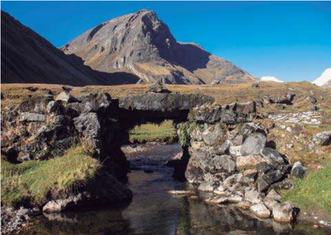
Foto 26. Celda o ventana este del puente inca de Huayllapampa (foto: Alfredo Bar)
