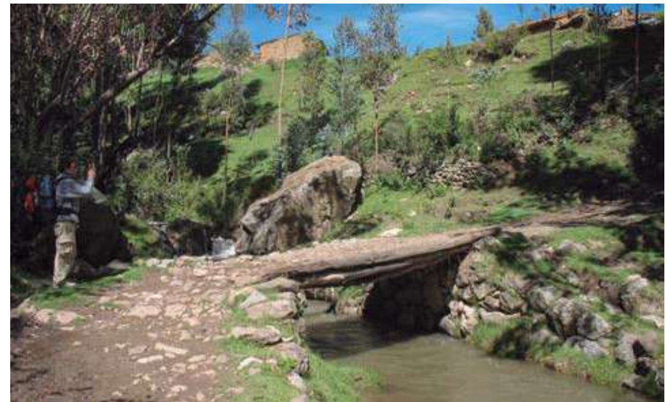
Foto 8. Puente en el río Acopampa (foto: Alfredo Bar)
