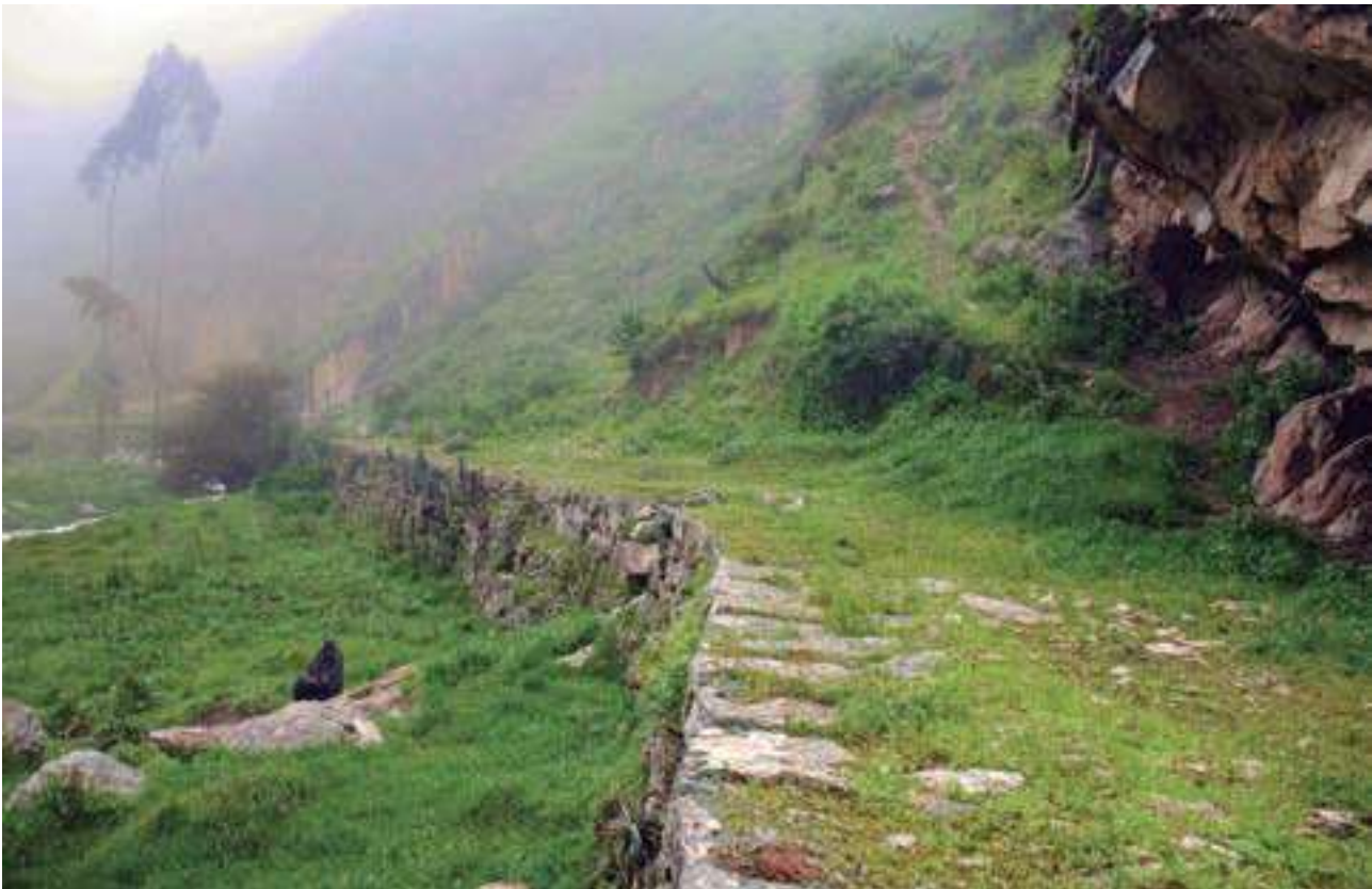
Foto 10. Camino en plataforma que va de Uchupampa a Tambo (foto: Alfredo Bar)
