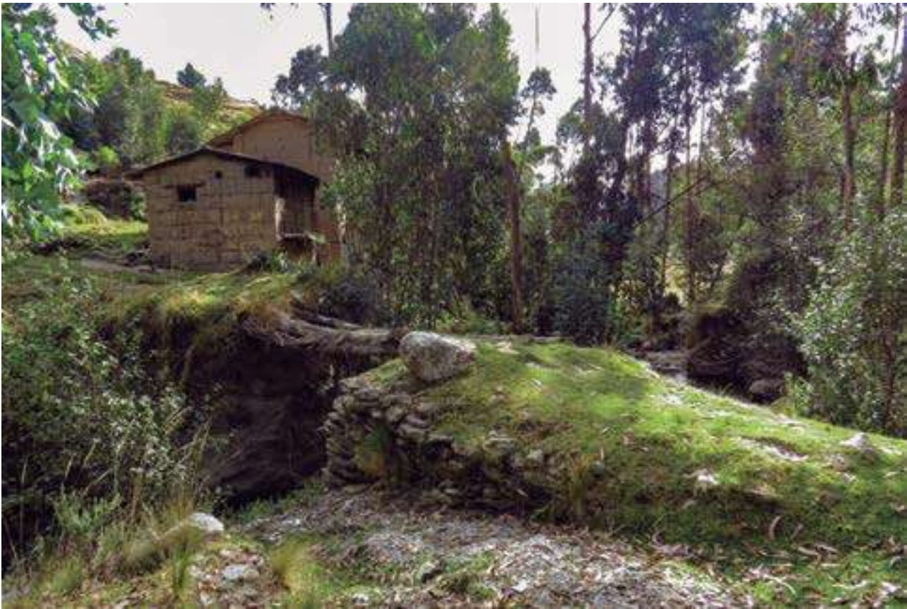
Foto 16: Estribos de piedra de antiguo puente sobre el río Choquevado (foto: Alfredo Bar)
