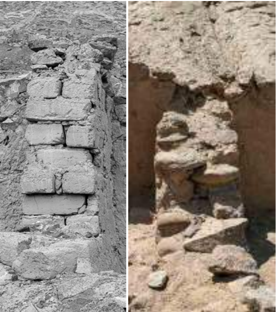
Fotos 6 y 7. Vista de la composición de un muro construido con bloques paralelipedos y otro con piedras unidas con mortero de barro arcilloso colocados a doble hilera formando muros de doble paramento (fotos por José Luis Díaz)
