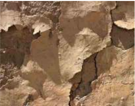
Foto 9. Detalle del enlucido original conservado en un muro
