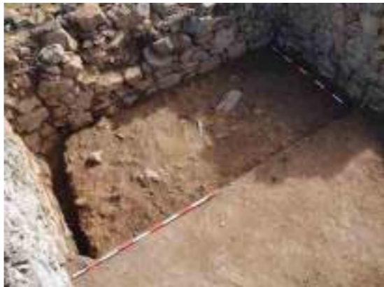
Foto 4. Técnica constructiva de muros construidos dentro de zanjas de cimentación
