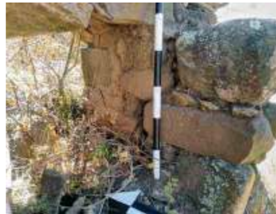
Foto 3. Detalle del mortero de barro ubicado entre las piedras
