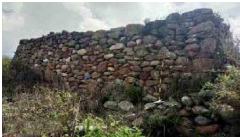
Foto 2. Tipo de aparejo rústico en colca de la Ladera Norte
