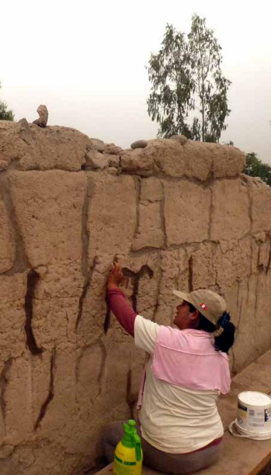
Esta técnica elimina la discontinuidad de los muros creada por las fisuras, lo cual constituye un proceso de reparación de muros históricos muy aceptable dentro de los criterios basados en la resistencia.
