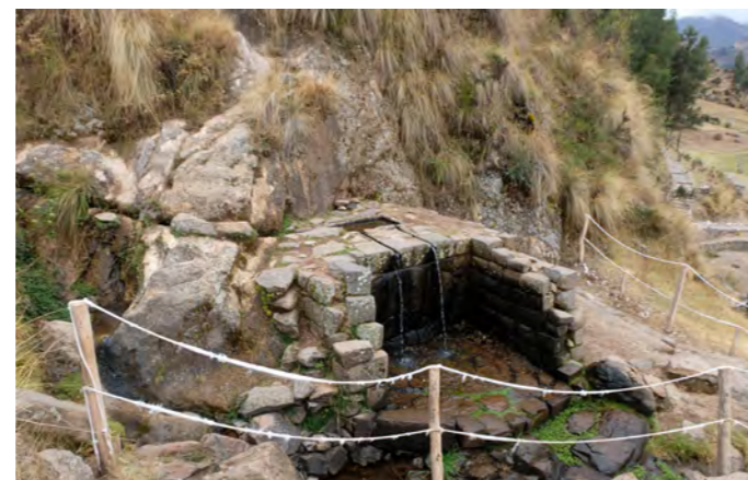
Foto 23. Manchas ocasionado por la presencia de humedad. Sitio Intihuatana. Fotografía: Iván Ccachura
