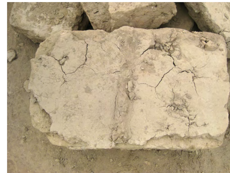
Foto 1. Lesiones visibles en un adobe. Sitio Tambo Colorado. Fotografía: Sergio Anchi
