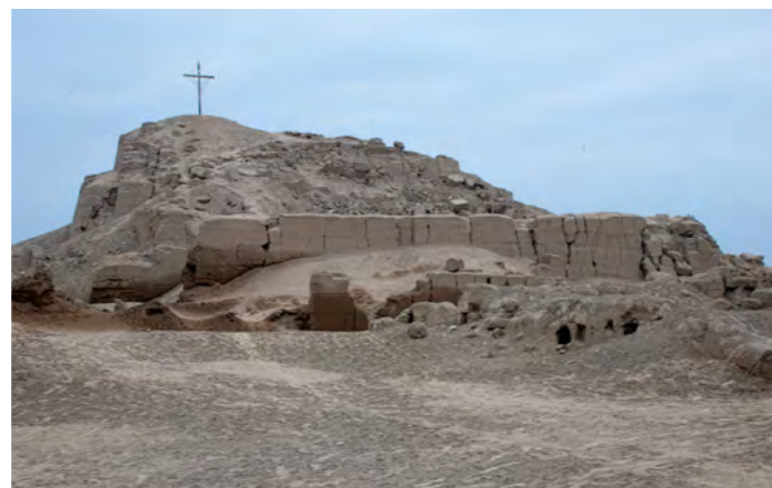
Foto 15. Presencia de humedad en muros del Sitio La Centinela. Fotografía: José Luis Matos
