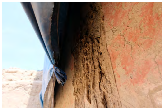
Foto 22. Lesión de la capa pictórica por sedimentación. Sitio Tambo Colorado. Fotografía: Iván Ccachura
