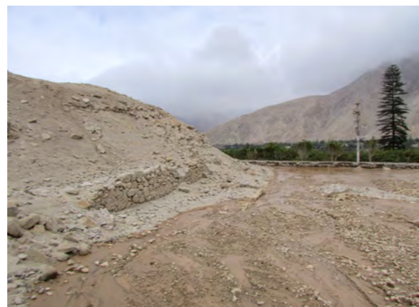
Foto 31. Daños ocasionados por deslizamiento. Sitio Incahuasi de Lunahuana. Fotografía: Iván Ccachura
