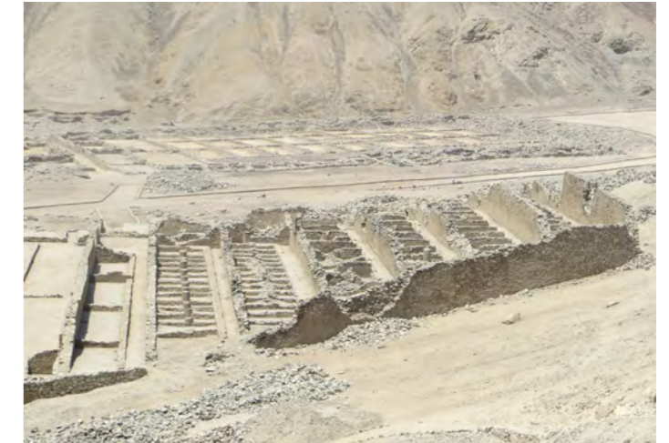
Foto 28. Caída de partes de muro por asentamiento del suelo. Sitio Incahuasi de Lunahuana. Fotografía: Iván Ccachura
