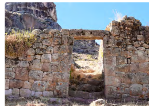
Foto 12. Presencia de hongos en superficies líticas. Incahuasi de Huaytará. Fotografía: Iván Ccachura
