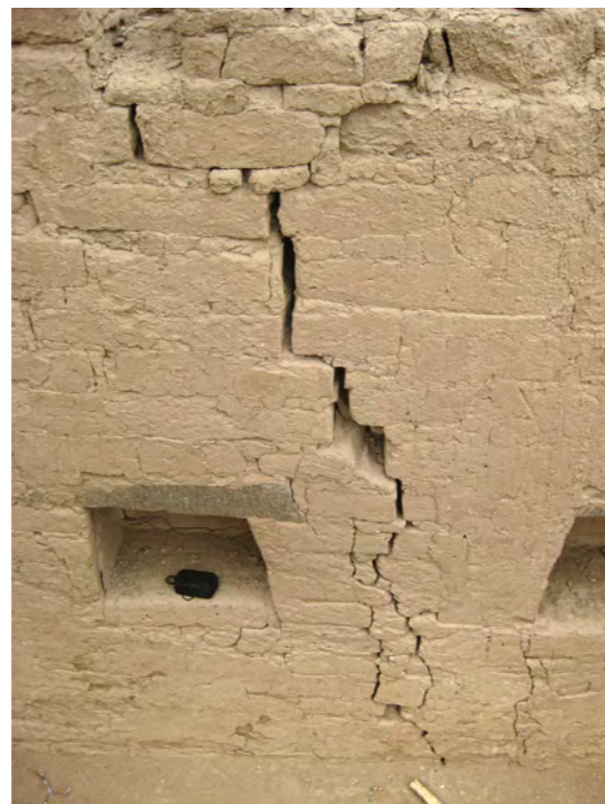
Foto 37. Fractura en secciones de muro. Sitio Tambo Colorado. Fotografía: Sergio Anchi
