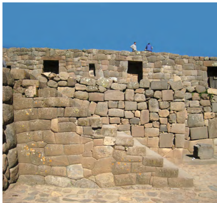
Foto 35. Intervenciones sin evidencias arqueológicas. Sitio Vilcashuamán. Fotografía: Sergio Anchi
