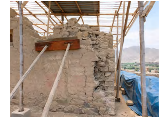
Foto 30. Evidencia de muros colapsados por empuje. Sitio Tambo Colorado. Fotografía: Iván Ccachura
