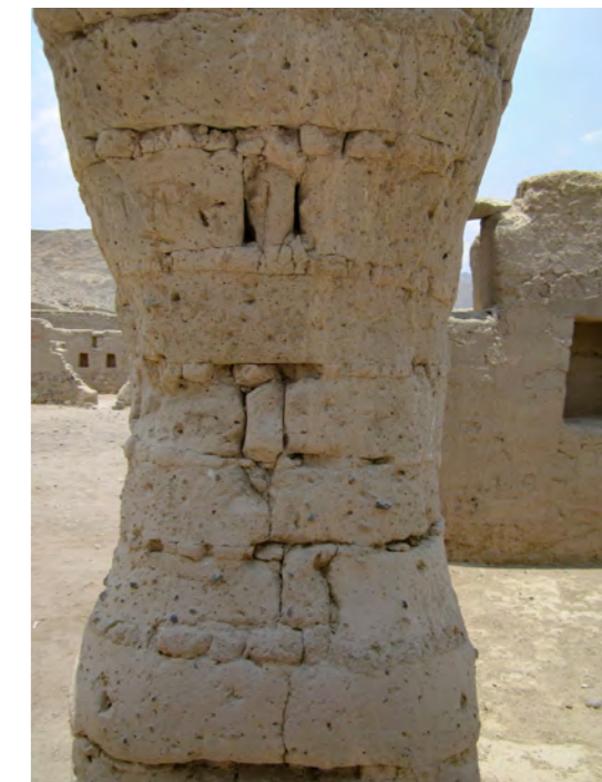
Foto 17. Efecto de la acción eólica. Sitio Tambo Colorado. Fotografía: Sergio Anchi
