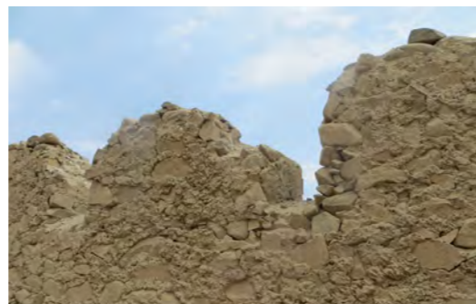
Foto 11. Deterioro por fisuras en la capa de recubrimiento o enlucido del muro. Sitio Incahuasi de Lunahuana. Fotografía: Iván Ccachura
