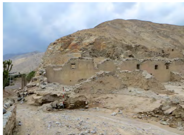
Foto 32. Perdida de estructuras por deslizamiento. Sitio Incahuasi de Lunahuana. Fotografía: Iván Ccachura
