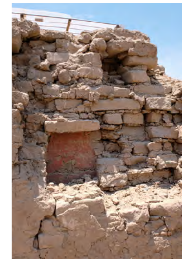
Foto 4. Pérdida de unidades de albañilería (adobes). Sitio Tambo Colorado. Fotografía: Iván Ccachura
