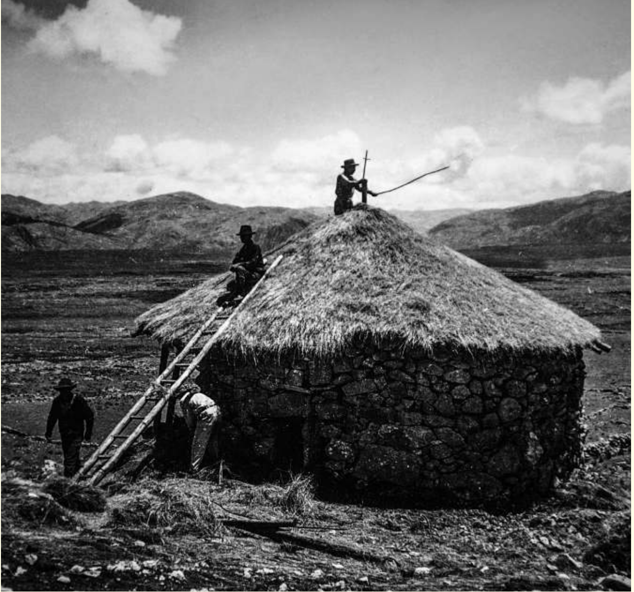
Proceso de reconstrucción del sistema de techado de una de las colcas de Huánuco Pampa
