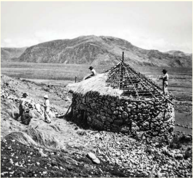
Proceso de reconstrucción del sistema de techado de una de las colcas de Huánuco Pampa
