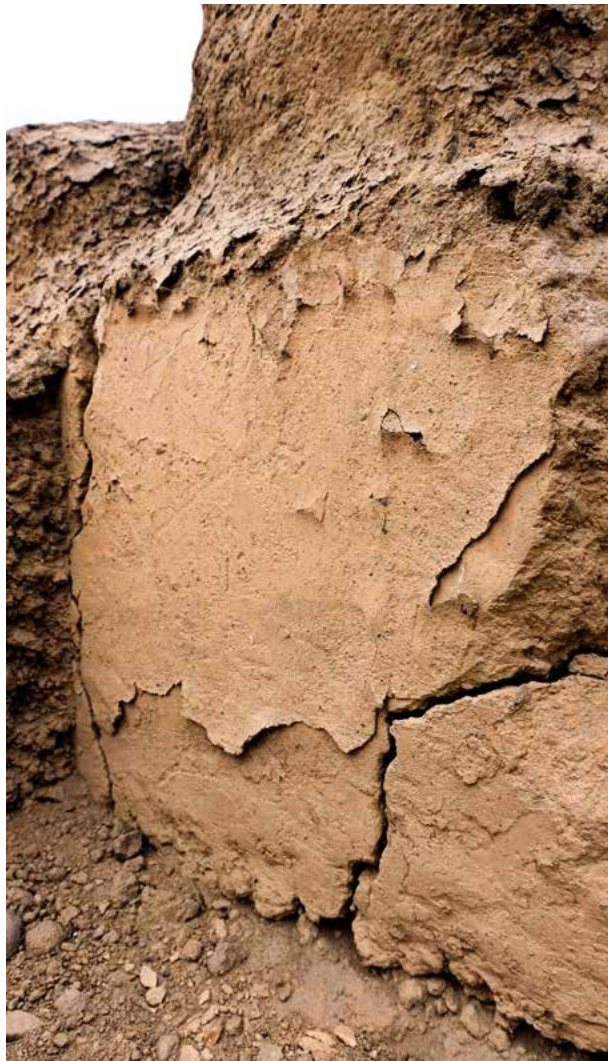
Foto 61. Capa de enlucido rojizo, ligeramente desprendido del paramento (forado del Templo Mayor) (foto por Pedro Espinoza, 2020).
