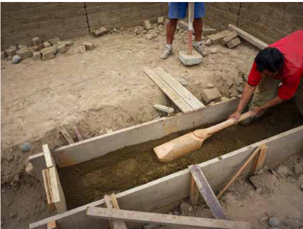
Foto 59. Elaboración de una tapia. La tierra humedecida y batida es compactada con pisonos y con un mazo de madera, dentro de un largo cajón hecho de tablas (Archivo fotográfico del Proyecto Mateo Salado, 2010).
