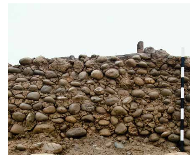
Foto 227. Muro de cantos rodados sin mortero. Jalón: 1 metro (Archivo fotográfico del Proyecto Mateo Salado, 2010).
