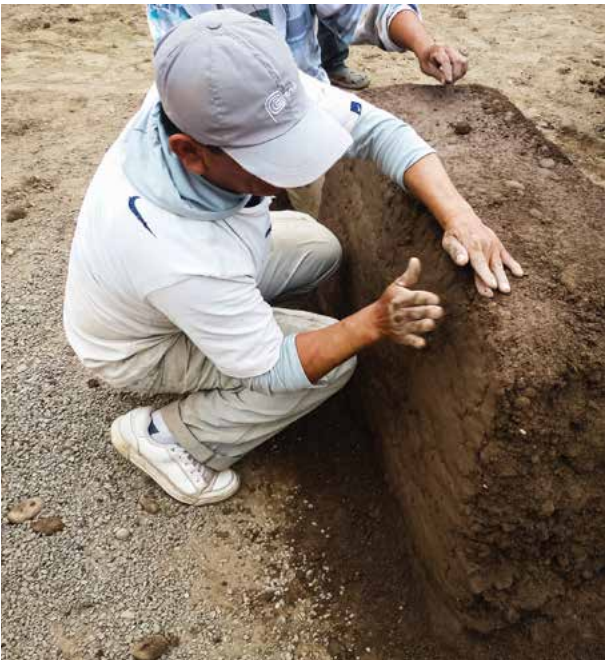
Foto 60. Elaboración de cob . El muro es directamente modelado con las manos, sin ayuda de moldes (Archivo fotográfico del Proyecto Mateo Salado, 2015).
