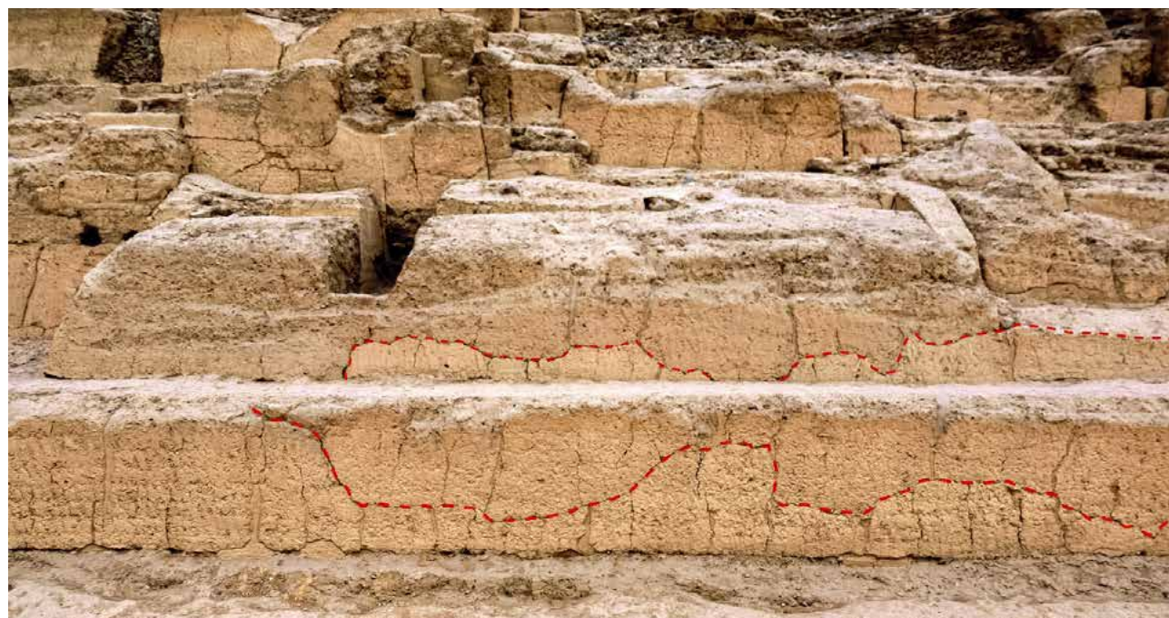
Foto 49. Marcas de rotura y reparación de muros en el frontis este de la Pirámide E (foto por Pedro Espinoza, 2020).
