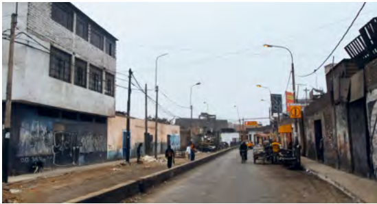
Foto 33. Trayectoria del camino en Jr. Huánuco, en el distrito de La Victoria.
